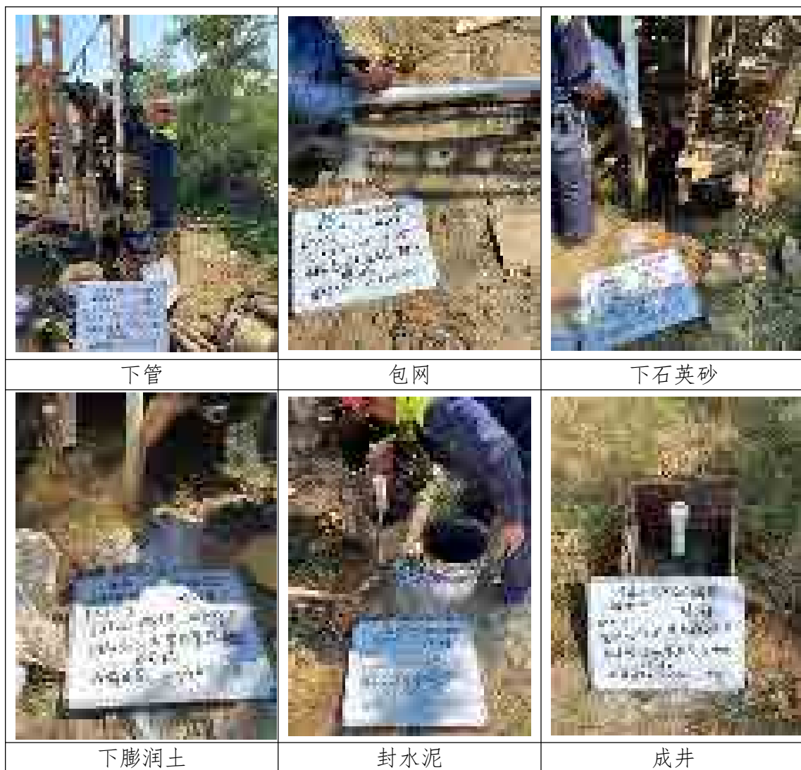
图 5.3-4 地下水建井过程影像图
